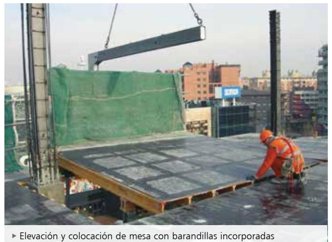
▶ Elevación y colocación de mesa con barandillas incorporadas
