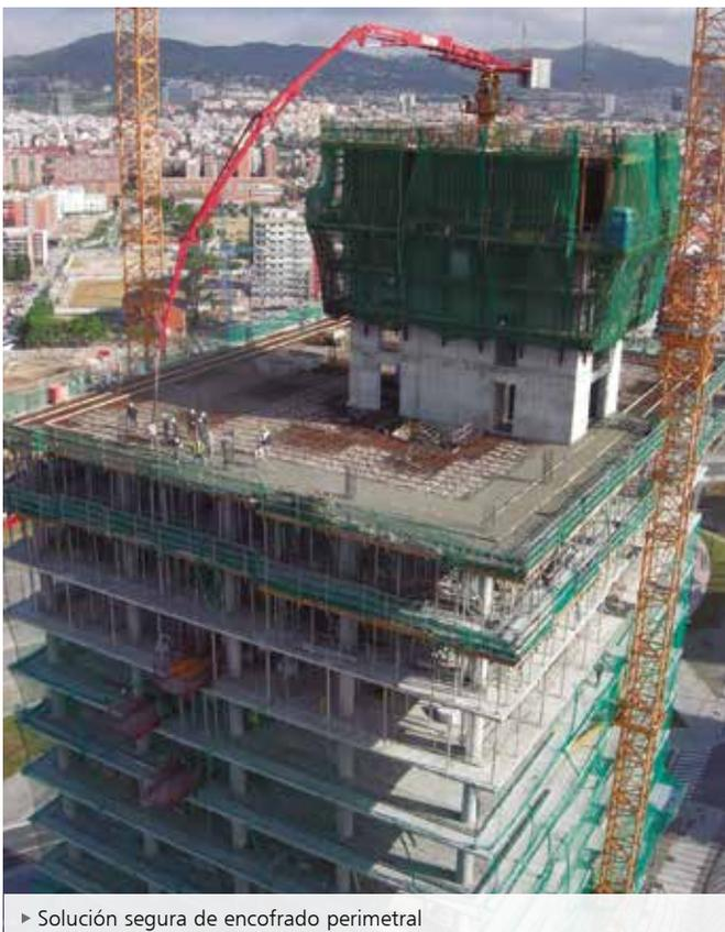
▶ Solución segura de encofrado perimetral
